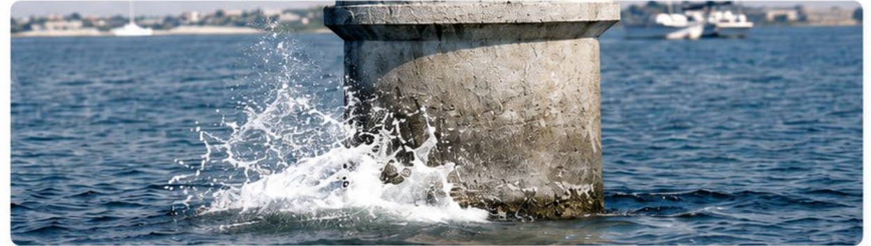
Skvalpzonen är ofta utsatt för salt-frostskador
