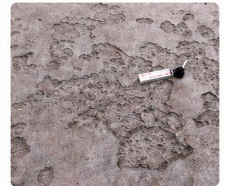
Salt-frost kan ge ytavskalning
