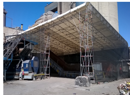
↑ Den tillfälliga lagerbyggnaden uppfördes under sommaren.
