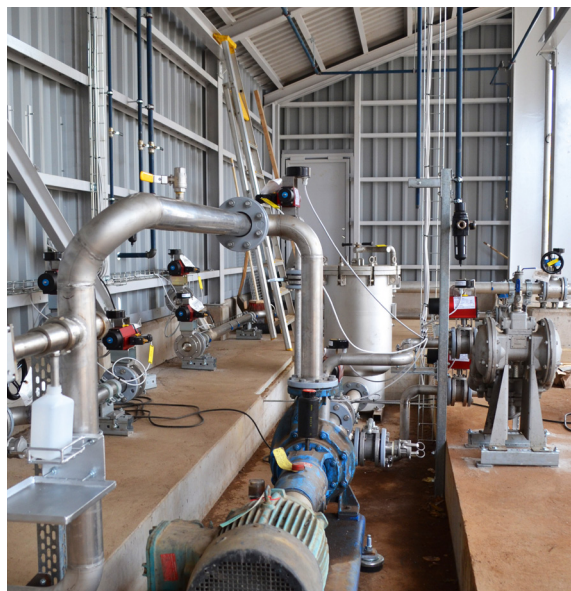
↑ En specialbyggd mottagningsstation gör hanteringen av AC-bränslen betydligt säkrare. Den kan liknas vid en omvänd bensinstation – tankbilar lossar de flytande massorna som förs vidare in i anläggningen där de nyttjas som bränsle.
