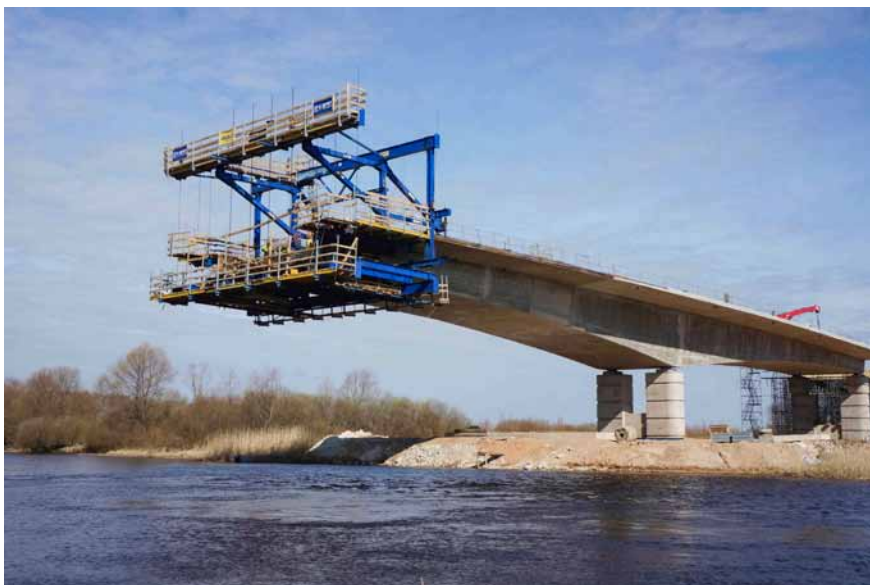
Brons mittdel byggdes i etapper om fem meter från vardera hållet. Efter varje etapp flyttades formvagnen fram ett stycke. En komplikation var att bron samtidigt skulle krökas både horisontellt och vertikalt.
