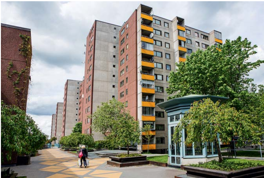
Miljonprogrammets betongfasader utgör redan ett ganska bra klimatskal, men med tätning av fogar och byten av fönster kommer uppvärmningskostnaderna att sänkas rejält.
