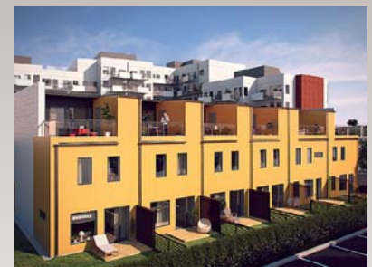
Stadsradhusen på Vänortsgatan i Mölndal har tunga fasader i betong och tegel samt ljudisolerade fönster.
