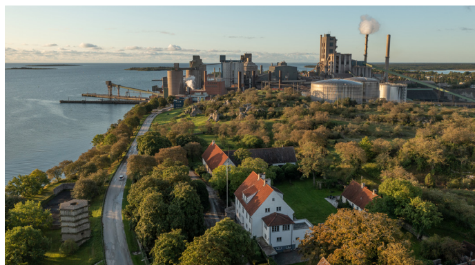
Slite CCS är en av flera hundra CCS-anläggningar som planeras runt om i världen.
